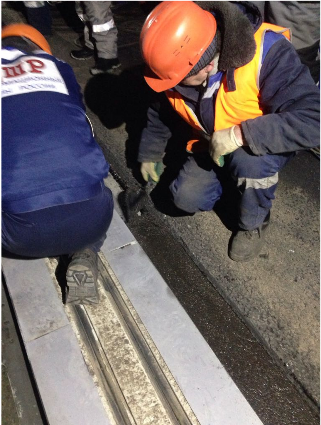
Заполнение штрабы полимербетоном «ДШКРИТФЛЕКС»
